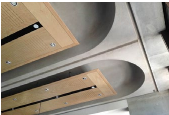
Перекрытия из геобетона
