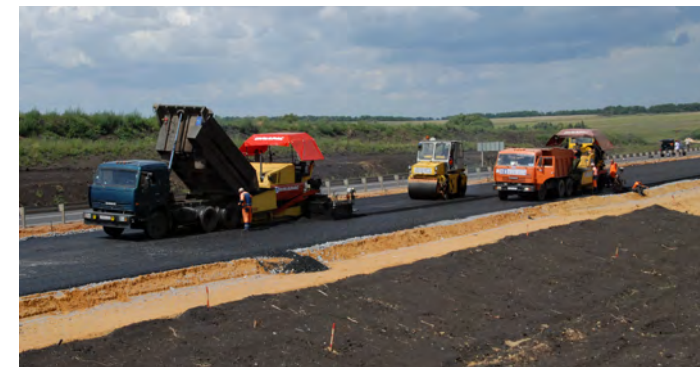
Укладка асфальтобетонного покрытия
