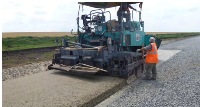
Укладка основания из тощего бетона
