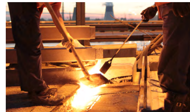
Устройство деформационных швов
