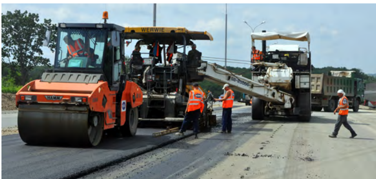
Укладка асфальтобетонного покрытия с помощью перегружателя
