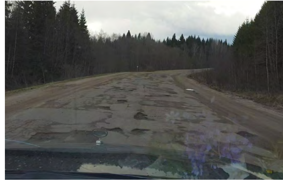
Дорога в районе п. Кесьма
