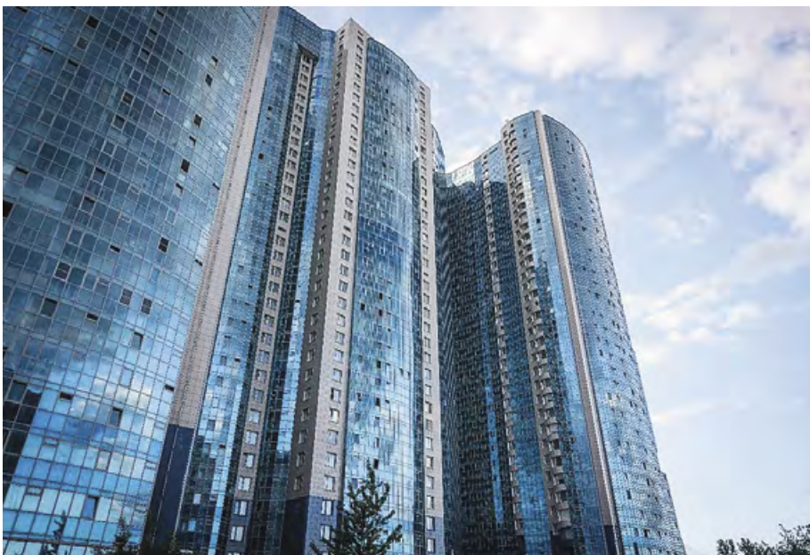
ЖК Князь Александр Невский, г. Санкт-Петербург. Используемые серии: витражная серия ТП-50300, окна ТП-45.
