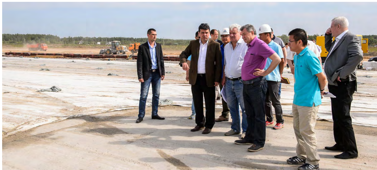
На строительстве взлетно-посадочной полосы Международного аэропорта «Калуга».
