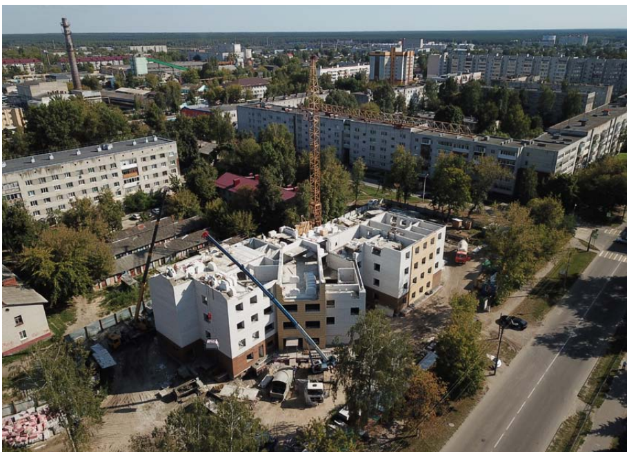
Стройплощадка детской поликлиники в Фокинском
