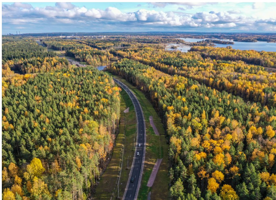
Реконструкция трассы сортавала
