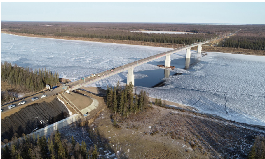
Мост через реку марха
