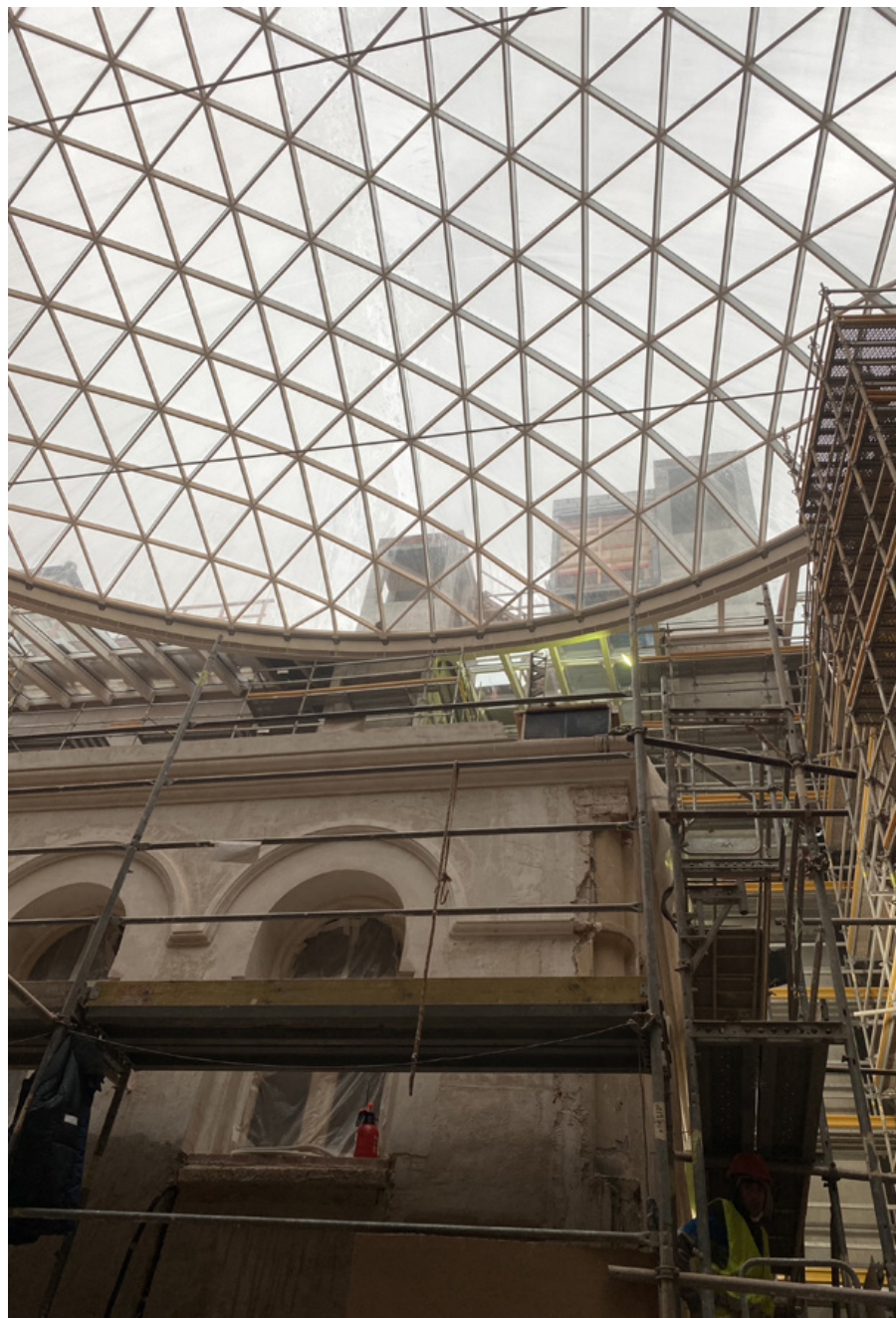
Кровля из светопрозрачных алюминиевых конструкций Политехнического музея будет использоваться для крепления полноразмерных макетов самолетов и космических кораблей
