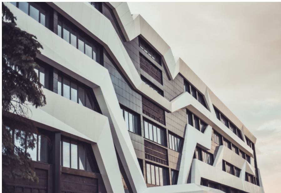
Алюминиевые элементы в отделке фасада бизнес-центра в Великом Новгороде
