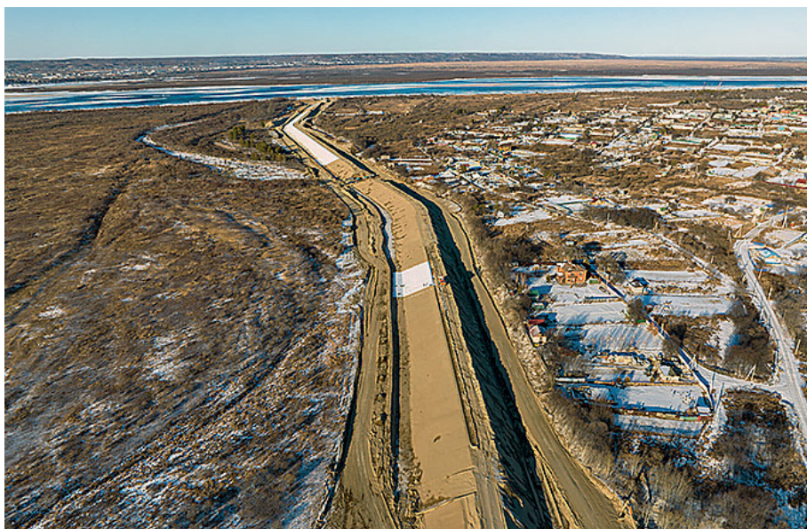
Строительство дамбы для защиты с. Владимировка от паводков в Амурской обл.
