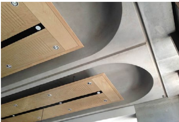
Перекрытия из геобетона
