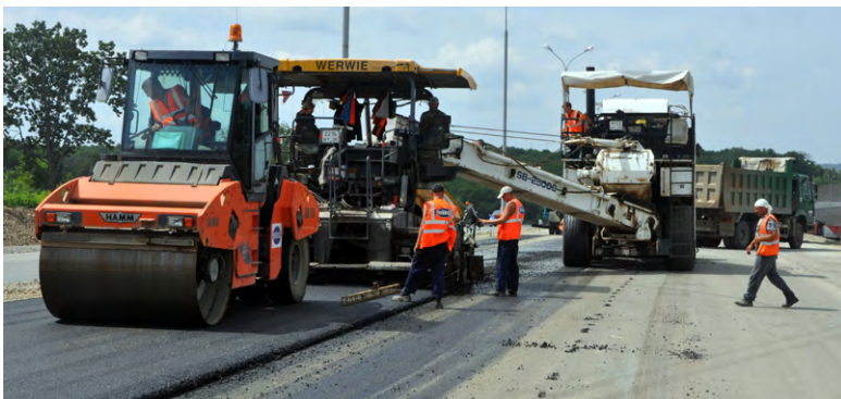
Укладка асфальтобетонного покрытия с помощью перегружателя
