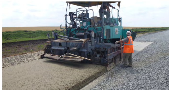
Укладка основания из тощего бетона
