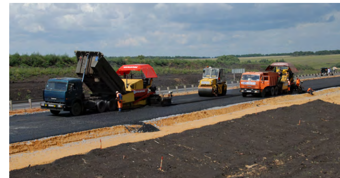
Укладка асфальтобетонного покрытия
