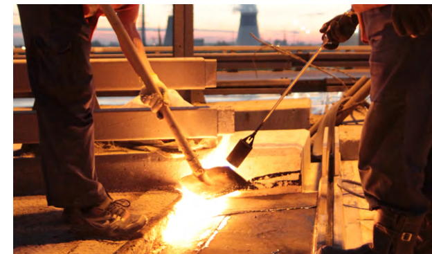
Устройство деформационных швов
