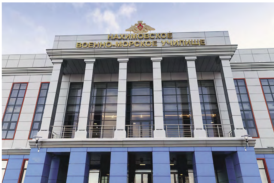
Нахимовское училище, г. Мурманск. Первый филиал Нахимовского военно-морского училища за Полярным кругом. Используемая серия: ЭК-640, ТП-50300, ТПТ-65.
