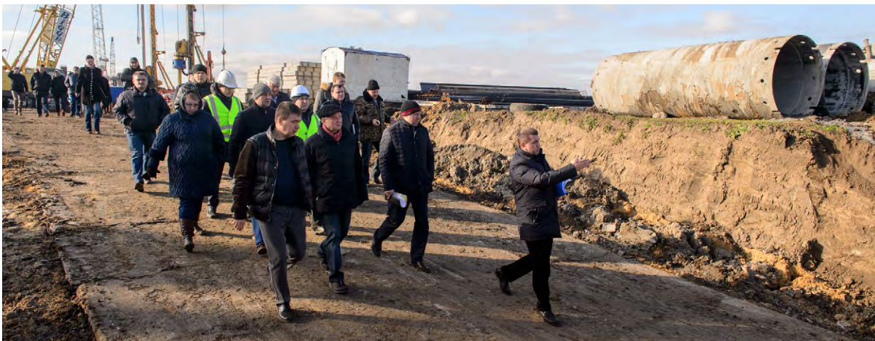
Строительство автомобильной трассы «Южный обход Калуги с мостом через реку Оку».
