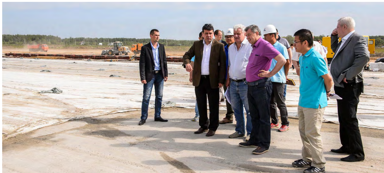
На строительстве взлетно-посадочной полосы Международного аэропорта «Калуга».
