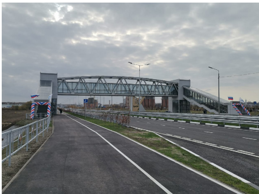
Тульский алюминиевый мост соединил парк Патриот-Тула и Тульское суворовское училище
