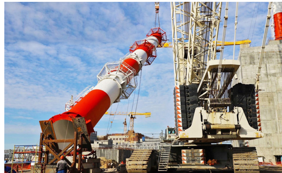
Курская АЭС. Монтаж вентиляционной трубы
