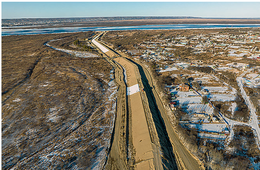
Строительство дамбы для защиты с. Владимировка от паводков в Амурской обл.
