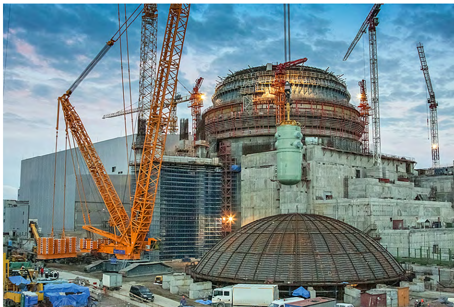
Монтаж корпуса реактора ЛАЭС-2 методом «Ореп-Тор»
